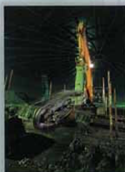
既設構造物直下の液状化対策
