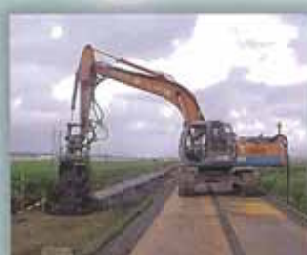
道路盛土の安定対策
