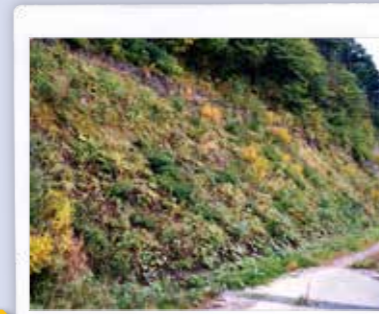
施工1年5ヵ月後
