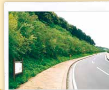
施工6年2ヵ月後
