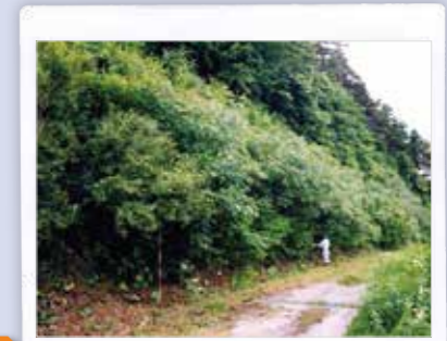
施工7年2ヵ月後
