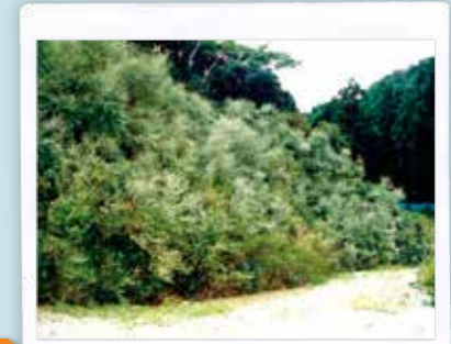
施工3年7ヵ月後
