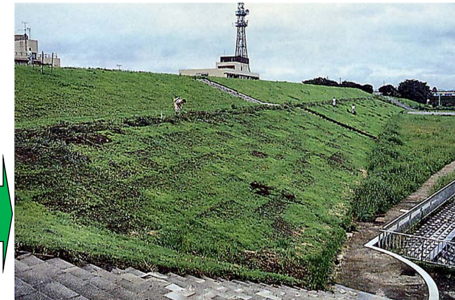
ノシバなどの成立により2段目の土堤（張芝工）と調和した修景効果が発揮されています。 (施工6ヵ月後)
