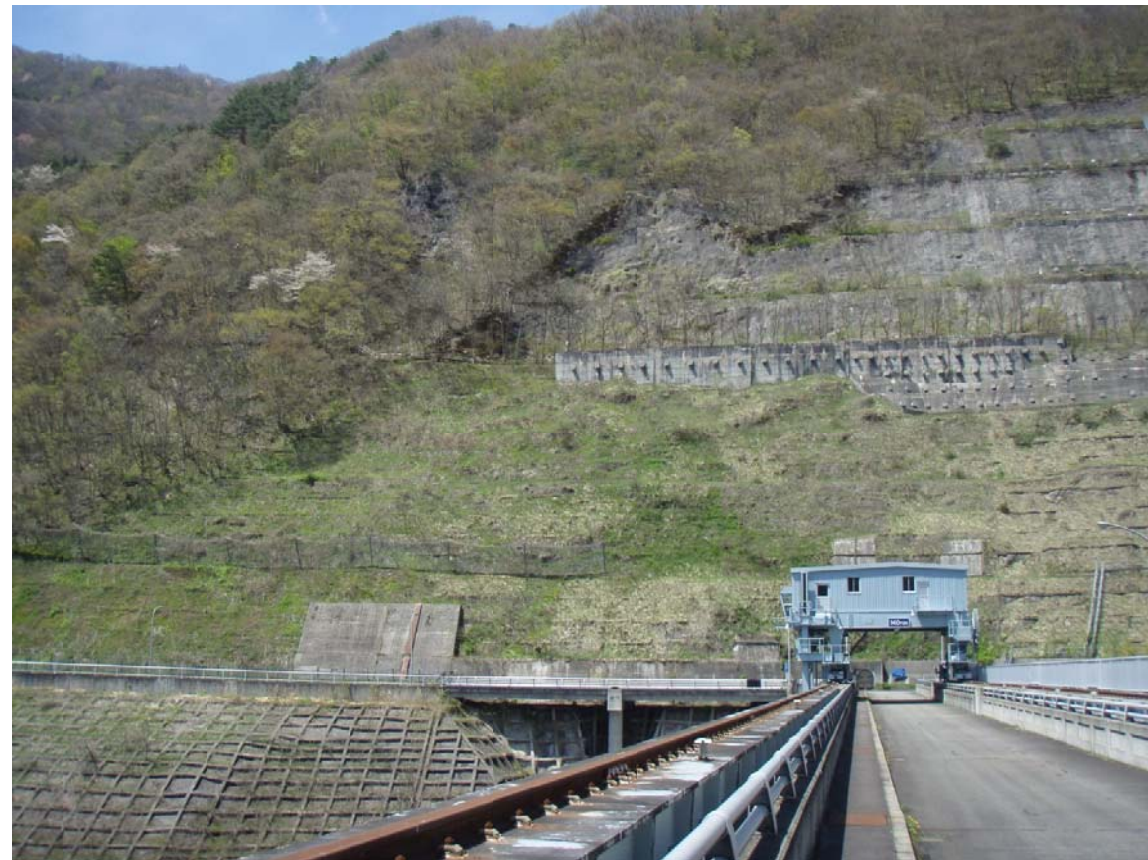
施工後28年が経過した現在でも植生が持続し、高い修景効果が発揮されています。 (施工28年後)
