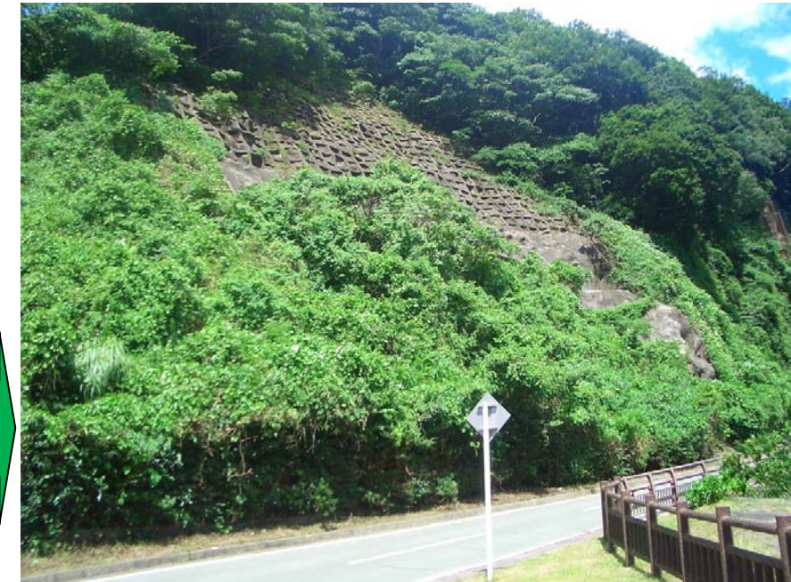
周辺の枠内緑化よりモルタル面を緑化した箇所（赤破線内）の方が樹林化され、高い修景効果が発揮されています。 (施工15年3ヵ月後)
