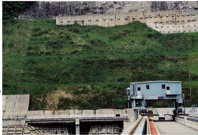
草本類で修景緑化されたモルタル吹付法面 (施工5年後)
