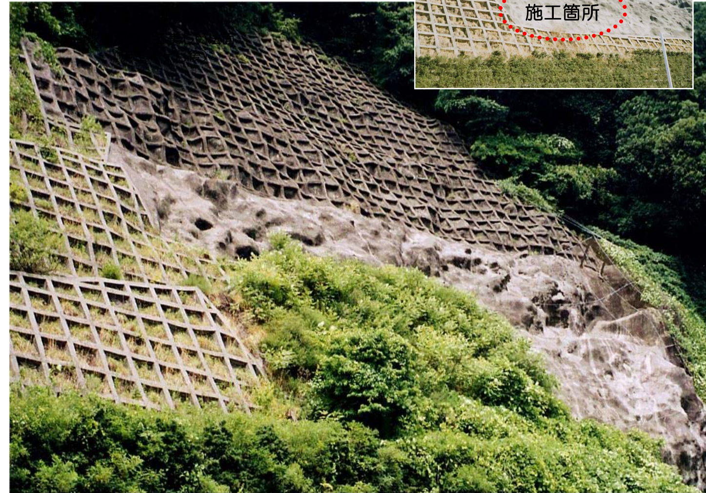
立野ダム（国交省）におけるモルタル吹付面の修景緑化（施工 6 年後：斜面樹林化工法 10cm 厚）
