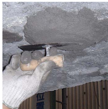
所定の厚さまで施工をおこ なってから表面を仕上げる
