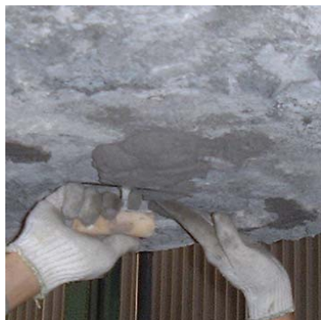
1層目を塗り込む 表面は荒仕上げで可
