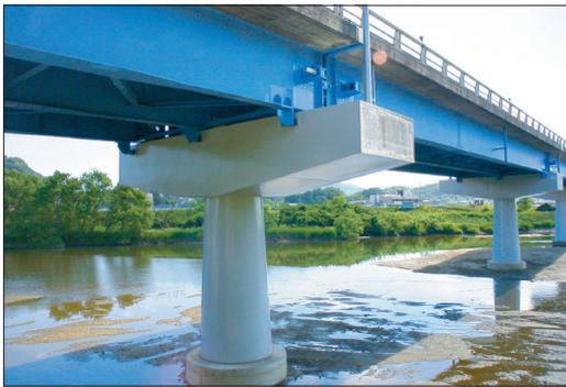
●橋脚の耐震補強工事(鋼板巻立て)
