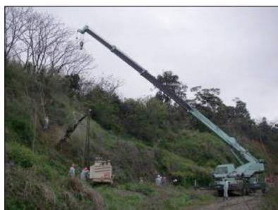
● ガイドセルクレーン吊下げ方式による施工
