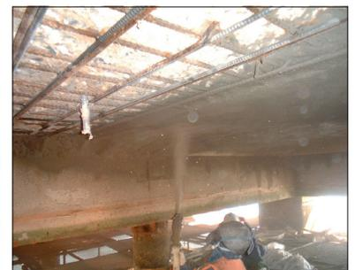
●乾式吹付による断面復旧工事
