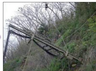
● ガイドセルクレーン吊下げ方式による削孔部拡大
