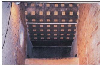
●都市ごみ焼却炉内部の耐火施工例
