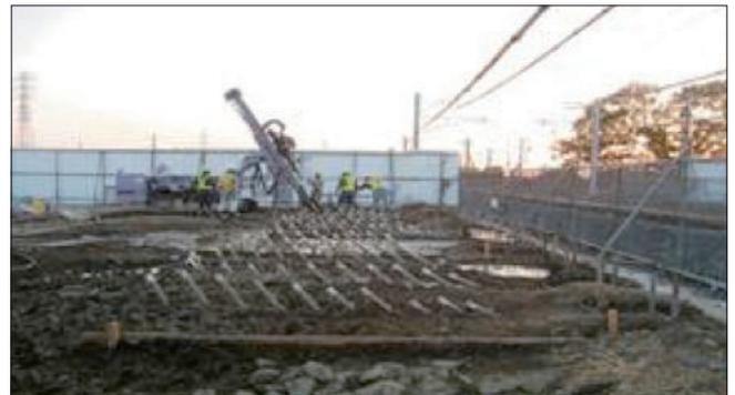
●ソレタンシュ工法注入管配置(軌道下:斜め施工)
