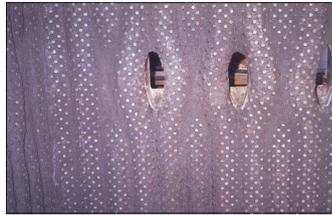
●ボイラー水管の耐火施工例
