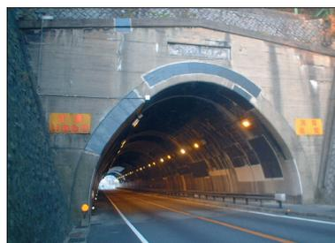
●炭素繊維シートによるトンネル補強工事
