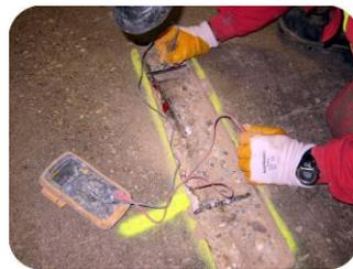
6. 結束ワイヤーと鉄筋の導通を確認します。
