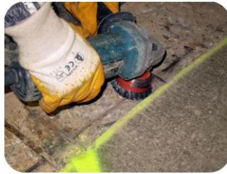
2. 結束ワイヤー取付け部の鉄筋を磨き面が出るまで研磨します。
