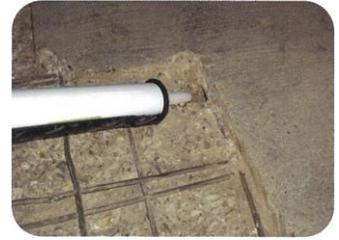
3. 孔の内部を水で清掃した後、専用バックフィル材を充填します。
