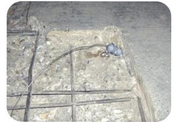
4. 孔の内部に陽極を挿入します。
