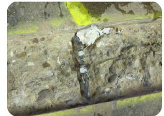
5. 陽極の結束ワイヤーを鉄筋の磨き面に巻付け、付属バンドで固定します。
