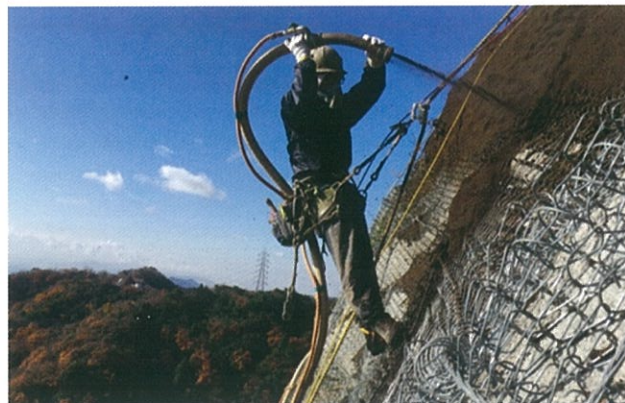
吹付状況(同上)
