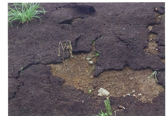
植生基材吹付工のラスなし施工
