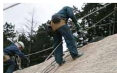
アンカーピンの打設
