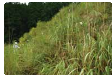
レミフォレスト工法で自然侵入した在来種で緑化された法面
