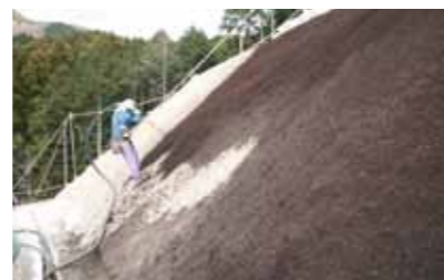
高耐久性基盤の吹付（ラスなし）
