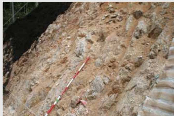
施工中 (凸凹の激しい岩盤法面)
