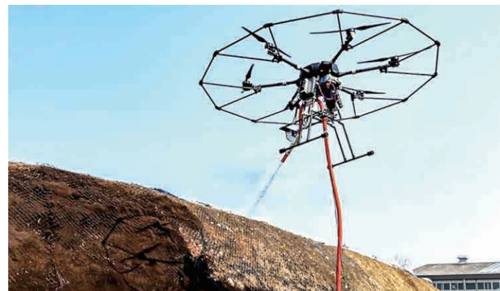
UAV 植生基材吹付工法（グリーンインパルス）の開発
