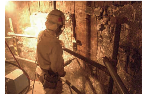
在来工法ライニング解体
