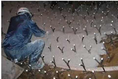
断熱材の施工状況
