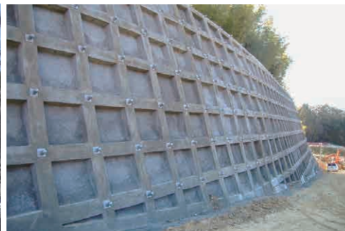
道路法面での事例（枠内ザルコン併用）
