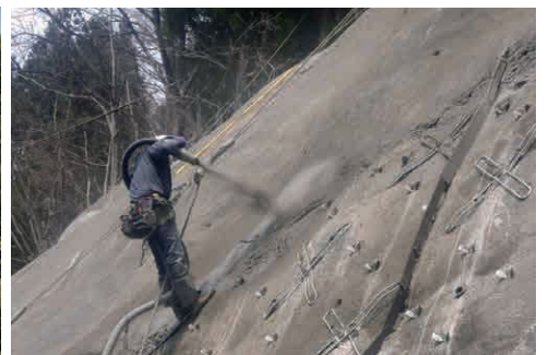
高品質モルタルの吹付状況
