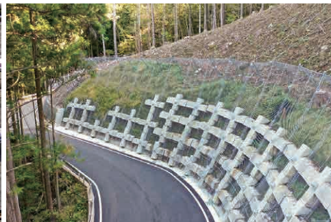
吹付法枠工との併用事例
