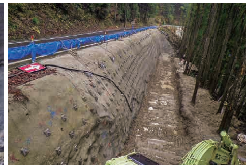
ロックボルト工（鉄筋挿入工）
