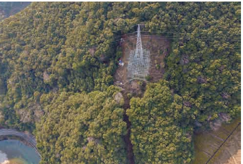
鉄塔下法面での事例
