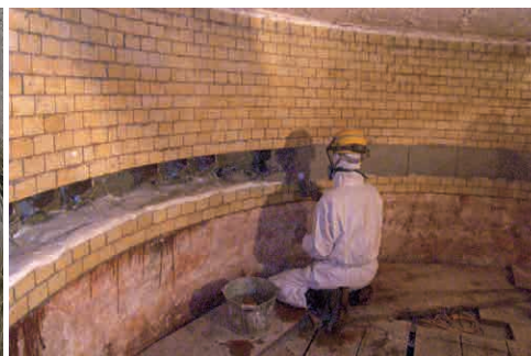
焼却炉壁施工状況
