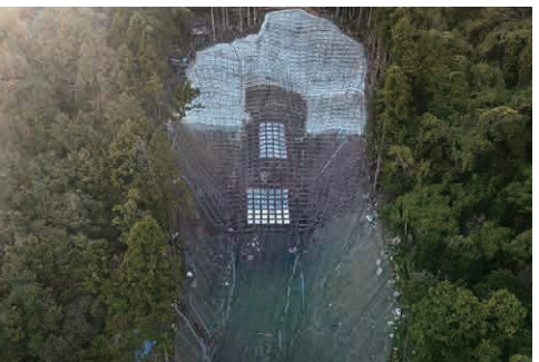
災害復旧現場での事例（施工中）
