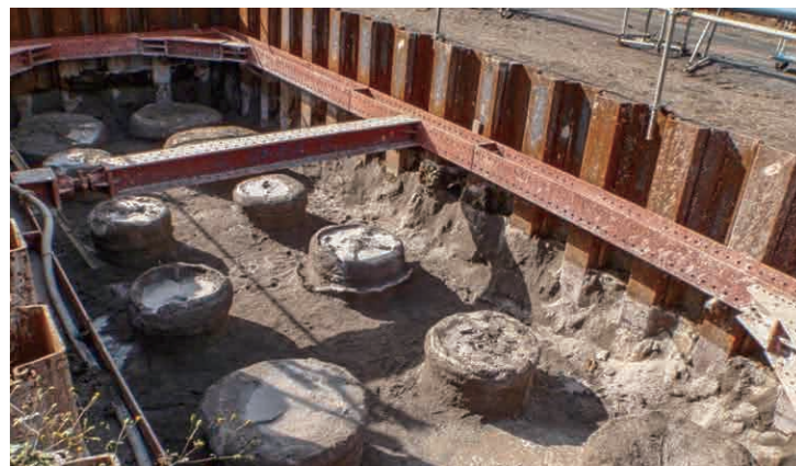
改良体造成実験
