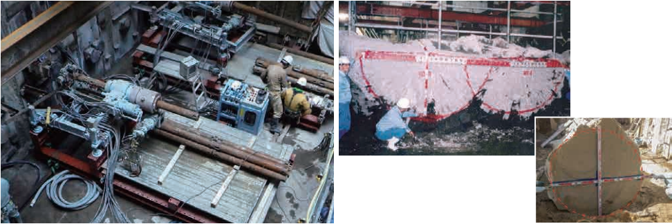
水平施工状況
