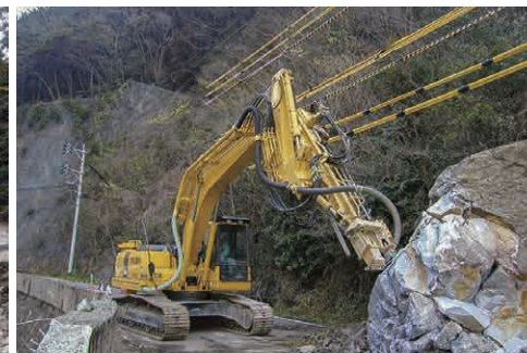
ビッガー工法（バックホウ取付式・パワースプリッター工法）
