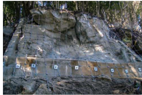
落石トメジローの施工事例
