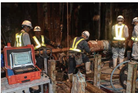
計測作業状況
