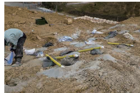
低振動蒸気破砕薬剤工法（ガンサイザー）
