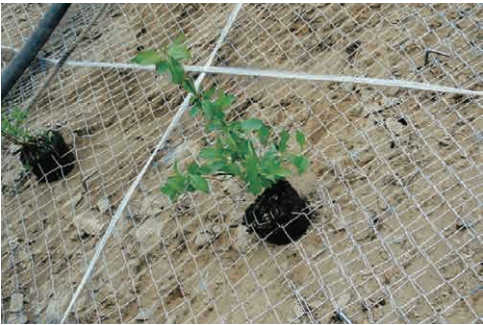
コンテナ苗の設置状況
