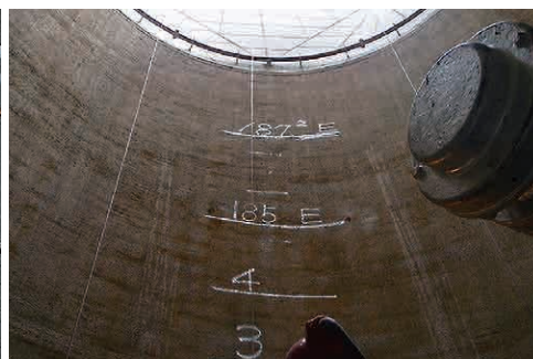
筒見内部の外観
