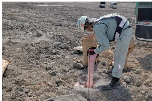
破砕材充填状況
