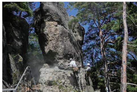
岩盤接着・根固め工の事例
