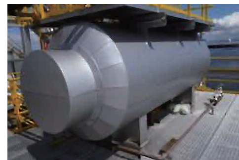
ドラムの施工状況
