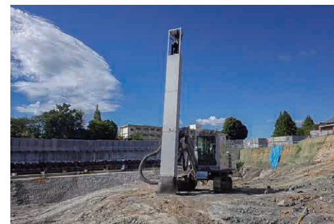
無振動静的破砕剤工法（ブライスター）
