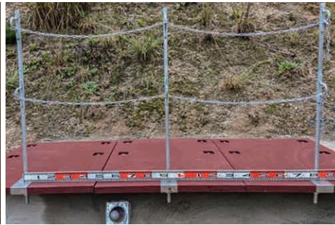
ヒロクナールの施工事例（試験施工）
