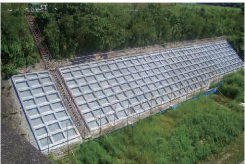
湧水法面での枠内吹付事例
