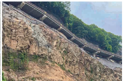
亀裂充填工の事例
