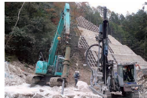
ビッガー工法（吊り下げ式）
