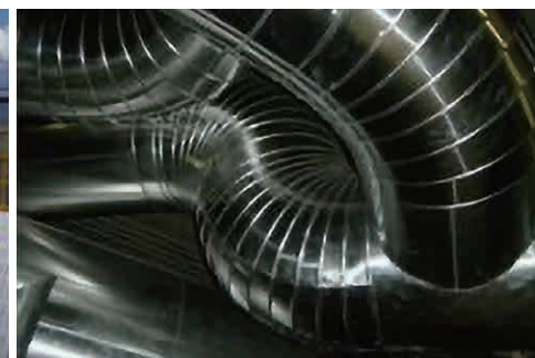
タービン廻り配管の施工状況
