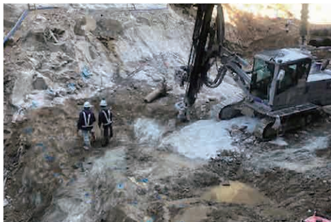
岩盤破砕（盤打ち発破）
