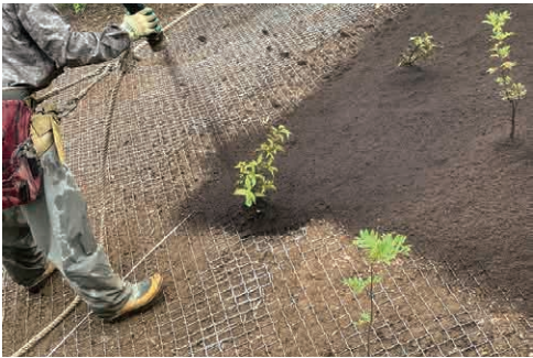
吹付植栽状況
