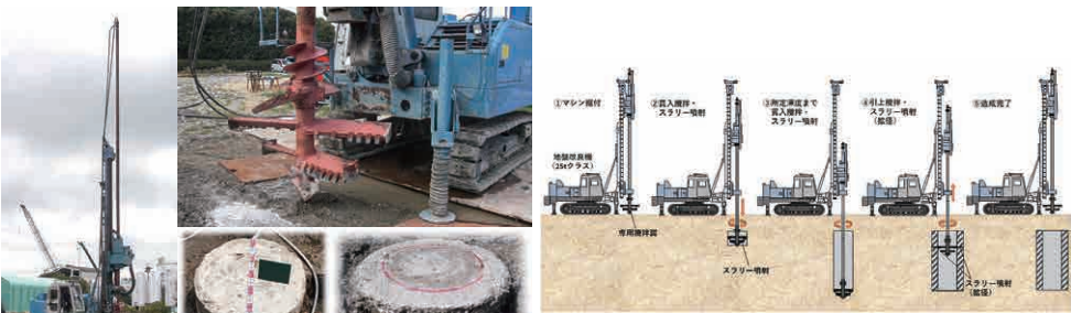
施工状況および改良体
