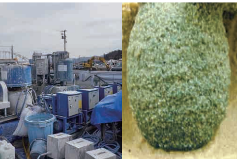
ソイルサポートエースによる施工状況 (二重管ダブルパッカー工法)・浸透状況
