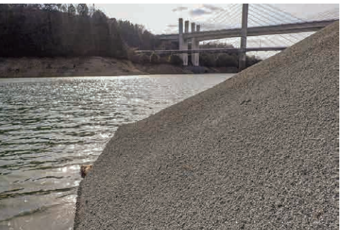
ダム湛水法面での事例
