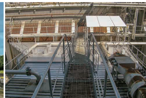
ダクト天面保温
