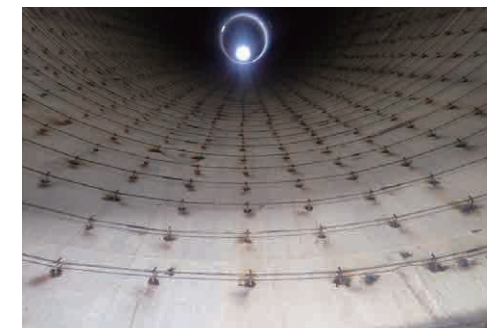
鉄筋配筋状況
