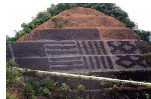
試験施工直後（国内産在来木本種子を使用）
