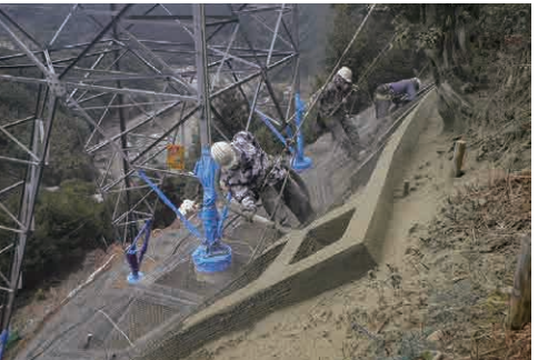
FCDモルタルの吹付状況
