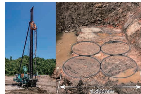
施工状況および改良体
