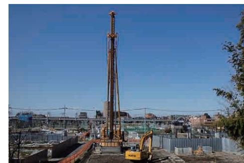
DJM 工法による施工状況
