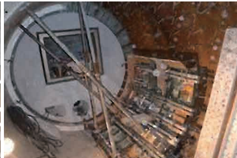
耐火材施工用型枠の施工状況
