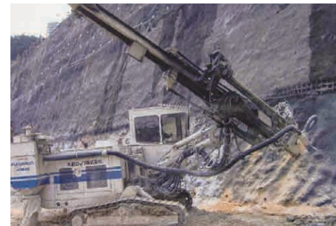
油圧クローラードリル穿孔（逆巻工法）
