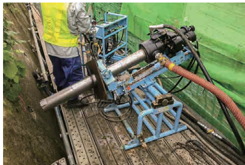
鉄道近接法面での事例（足場幅 W=1200～1600mm）
