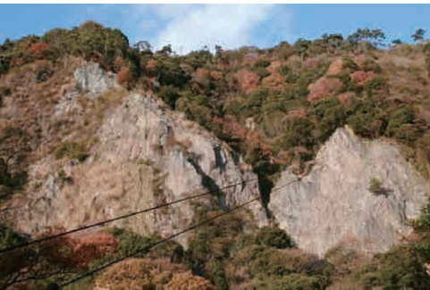
施工中（国内産在来木本種子を使用）
