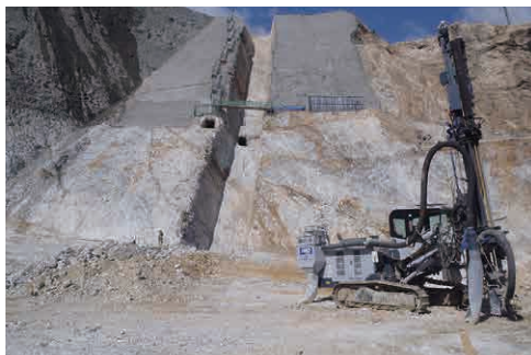
ベンチ発破（ダム基礎）
