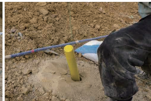
低振動蒸気破砕薬剤工法（ガンサイザー）
