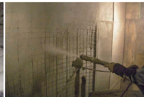
吹付工法による煙突内部のライニング施工状況
