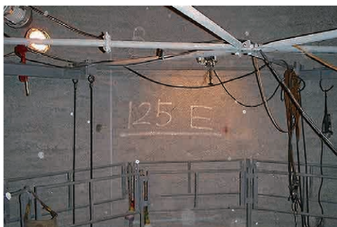
点検用ゴンドラの架設
