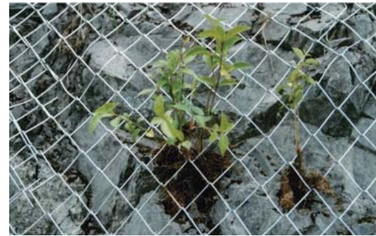
山取苗タイプ(岩盤の節理への苗木の設置状況)
