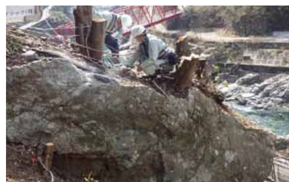
オーリスによる転石根入れ深さ計測
