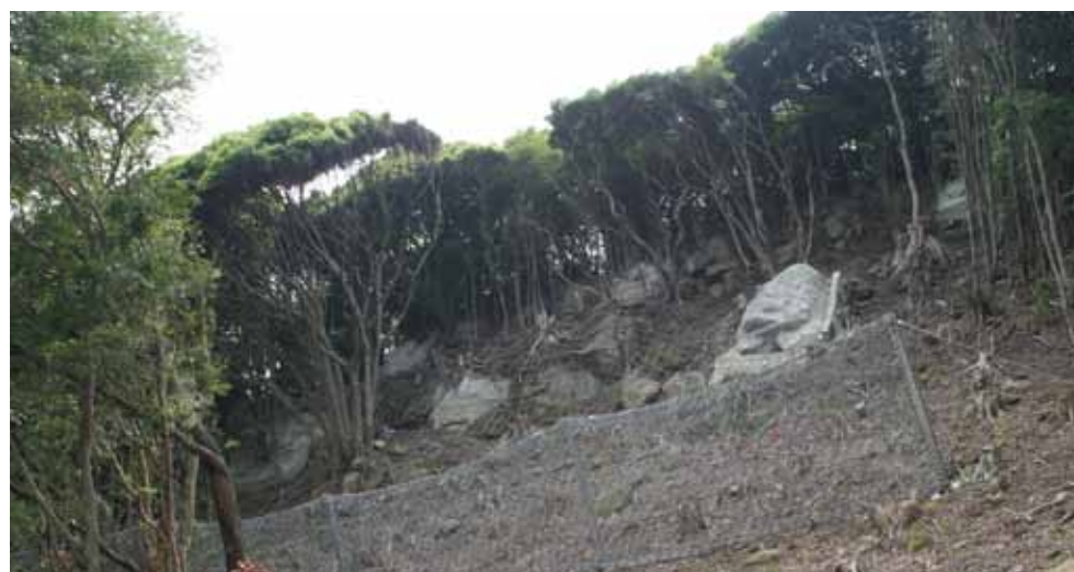
高エネルギー吸収柵で抑止できない300tクラスの巨岩に対する施工事例
