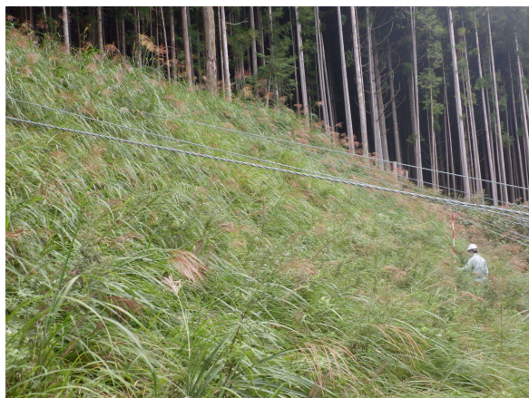
施工1年5ヵ月後（愛知県：シカの生息する地域でチカラシバ、ススキなど導入した法面）
