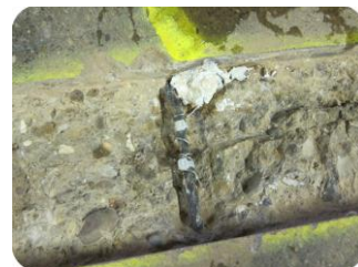
5. 陽極の結束線を鉄筋の磨き面に巻付け、結束バンドで固定します。
