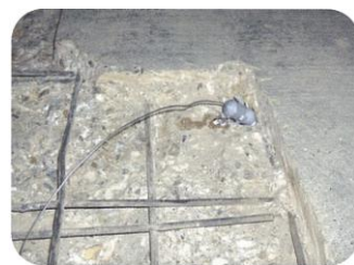
4. 孔の内部に陽極を挿入します。
