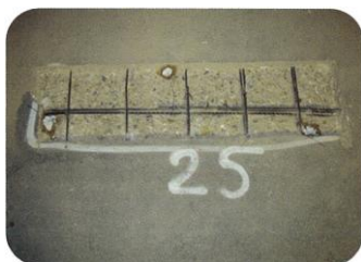
7. 施工完了。(埋め戻し前状況)
