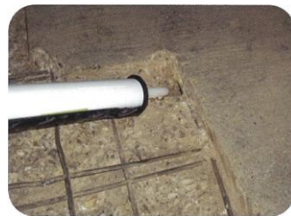
3. 孔の内部を水で清掃した後、専用バックフィル材を充填します。
