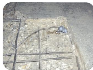
4. 孔の内部に陽極を挿入します。
