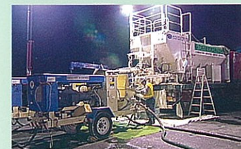
低流動性モルタルを圧送する強力なCPGポンプ
