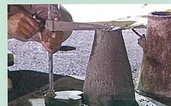
大切な材料管理、スランプ試験
