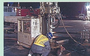
削孔スライムもすべて回収
