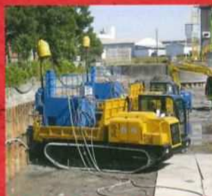
▲自走式機械(キャリアタンク)施工
