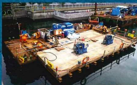
▲改良台船施工
