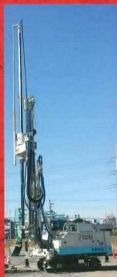
▲自走式機械(ミニ杭打機)施工
