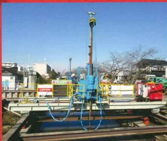
▲移動式架台(スライドベース)施工
