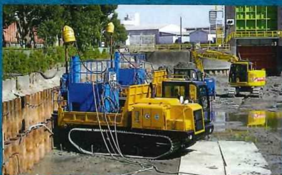
▲自走式機械(キャリアタンク)施工
