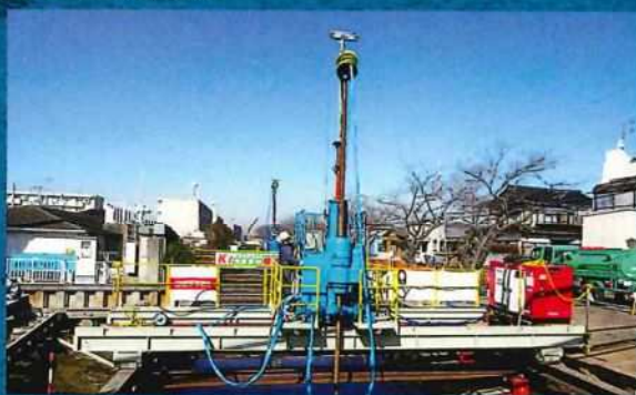
▲移動式架台(スライドベース)施工
