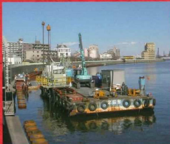
▲改良台船施工
