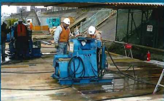
▲空頭制限施工
