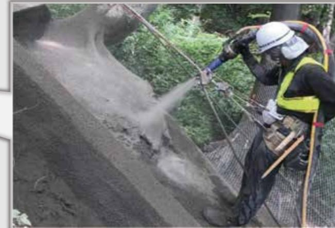
転石一体化根固め工(落石トメタロー)に適用
