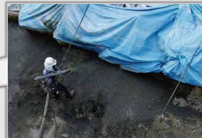
透水性コンクリート吹付工(ザルコン)に適用
