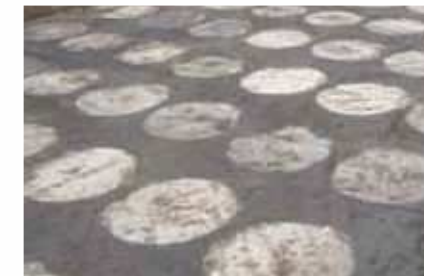
杭頭部確認状況
