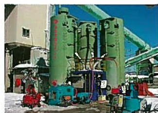
場外プラント設置状況
