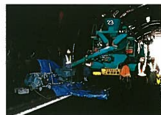
JETMS場内圧送例
