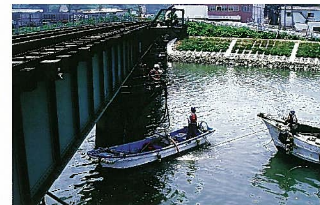
水中打設状況
