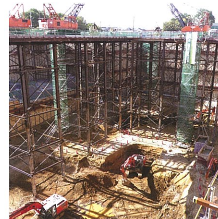
練馬清掃工場建替工事
