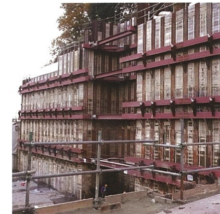
ネクサスコート黒川新築工事
