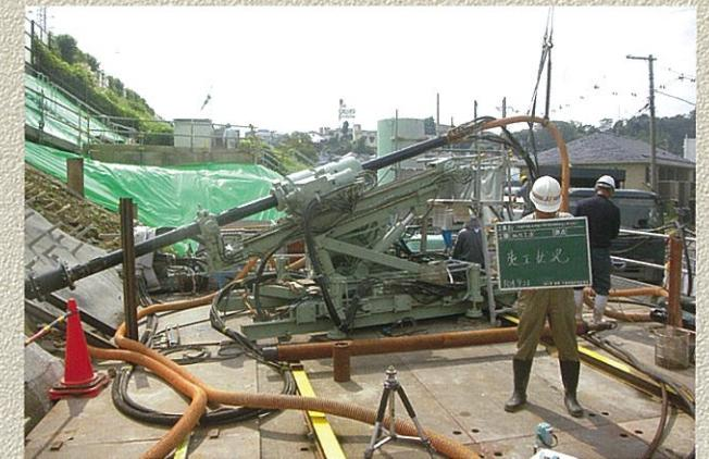
施工順序：斜め施工における多孔管使用の場合
