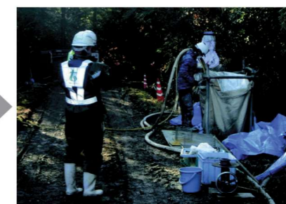
キャリブレーション NJSモルタル吐出量と送水量の測定
