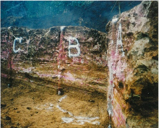
揺動施工による造成杭
