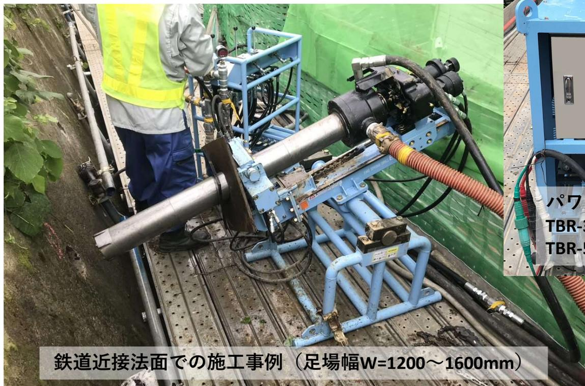
鉄道近接法面での施工事例（足場幅W=1200～1600mm）
