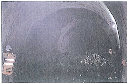
トンネル破碎
