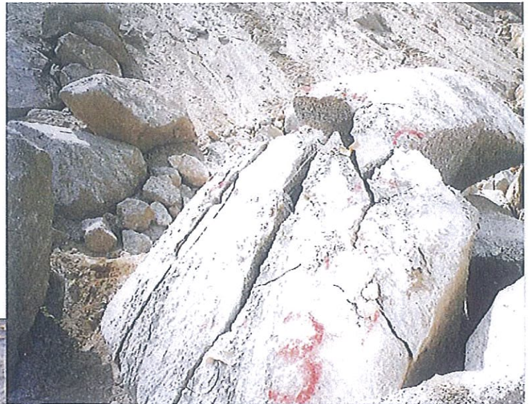
転石の破碎(ビット径42mm)
