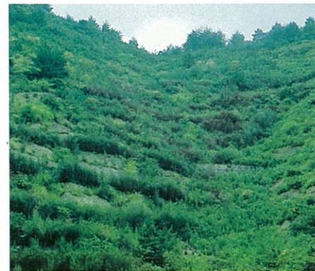
施工後1年3ヶ月
