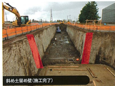
斜め土留め壁 (施工中)
