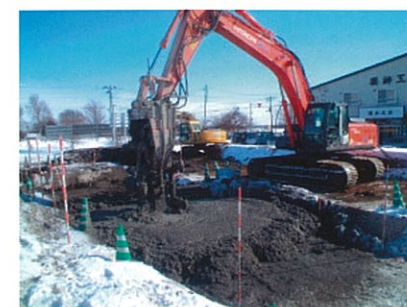
ヒートソイル工法
