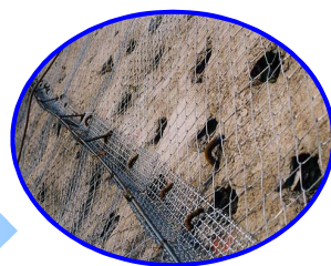
穿孔工と編柵補助金網 生育基盤の保持と、勾配を緩和する目的で編柵補助金網を設置。
