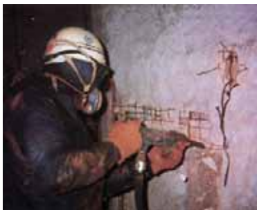
既設ライニングの解体
