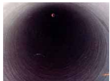
補修工事完了
