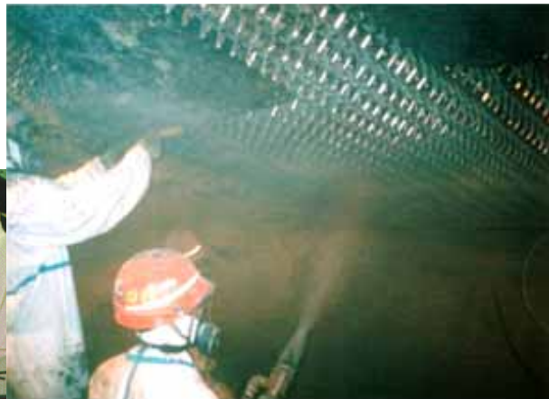
低セメント系材料吹付け材 湿式吹付け施工中 RSC-60WG RSC-45WG RSC-30WG
