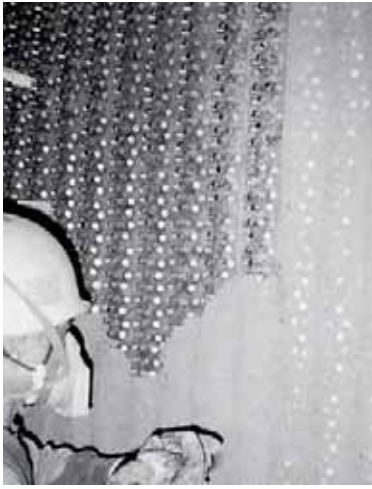
叩き込み施工用材料 施工中 PSP-80 PSP-30 PAT-SC75 MUC-SC80 MUC-SC30
