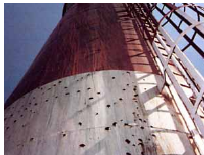
板厚測定、発錆状況、塗膜剥離状況よごれの点検
