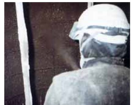
吹き付け施工
