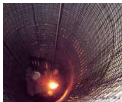
補強金物の取り付け
