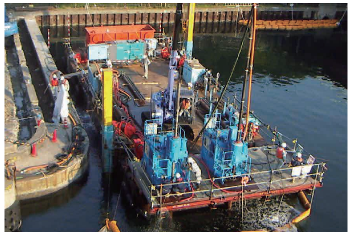
既設水門耐震補強工事
