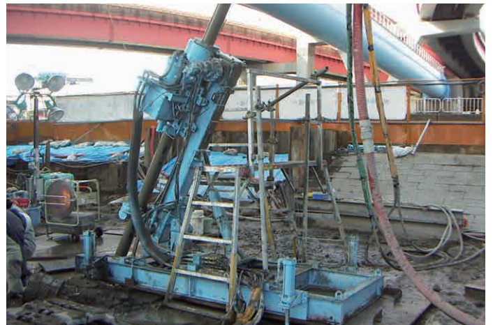
水管橋耐震補強工事
