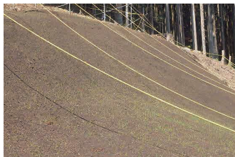
2019年4月(施工直後)
