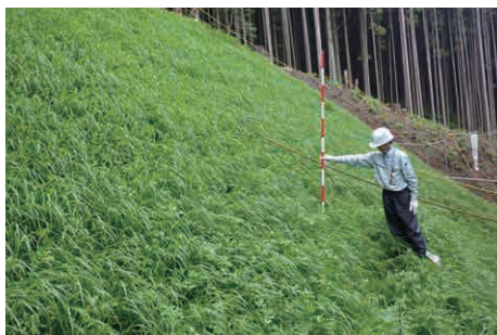
2019年6月(施工2ヵ月後)
