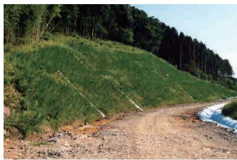
1996年9月(施工7ヵ月後)
