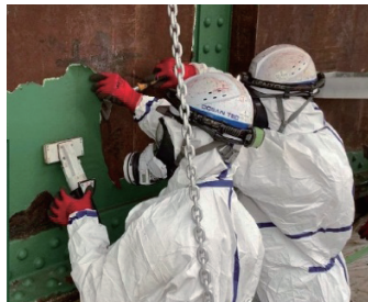
IH式塗膜剥離工法
