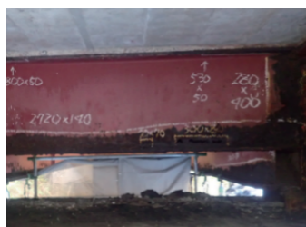
当て板施工前
