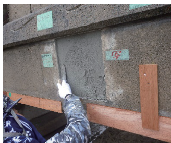
断面修復(左官工法)
