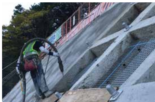
吹付枠の枠内吹付状況(特殊金網型枠併用)
