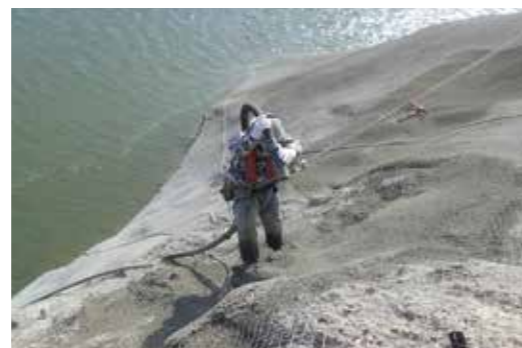
ダム湛水面の吹付状況
