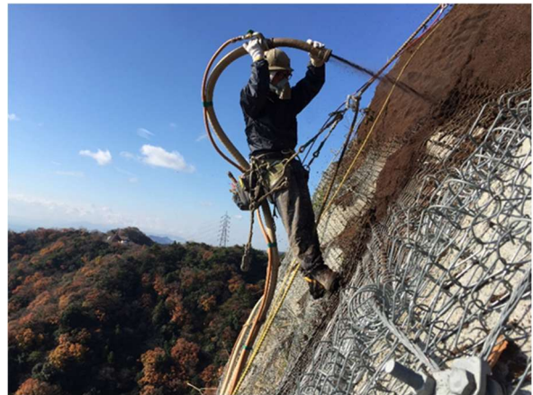
作業員による法面吹付施工
