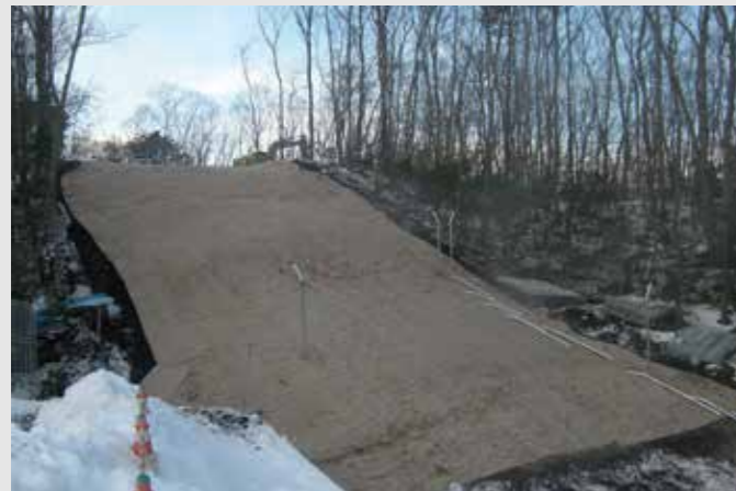
施工直後 ※旧シードキャッチャー（亀甲金網タイプ）を使用
