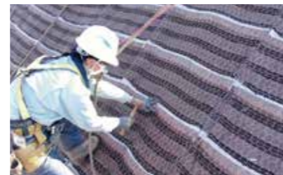
アンカーピンの打設
