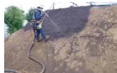
高耐久性基盤の吹付(ラスなし)
