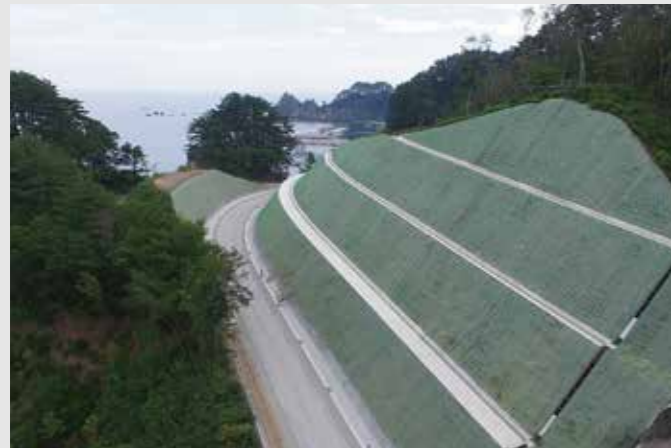
施工直後 ※旧シードキャッチャー（樹脂ネットタイプ）を使用
