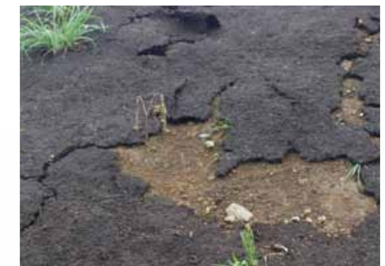
植生基材吹付工のラスなし施工
