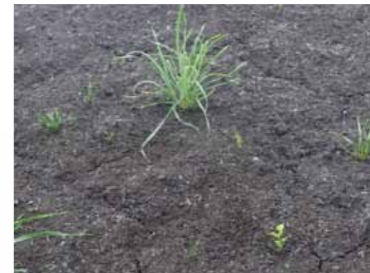
ノンラスグリーン工法
