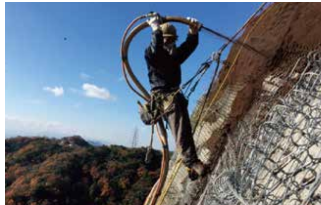
吹付状況(同上)
