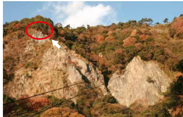
法面垂直高140m地点における施工状況
