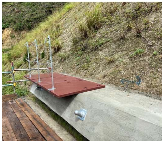
高強度軽量歩行板設置工
