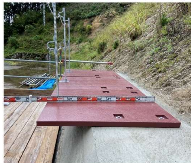
高強度軽量歩行板設置工
