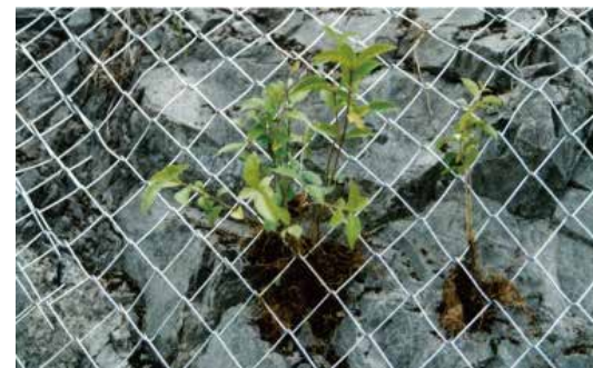
山取苗タイプ(岩盤の節理への苗木の設置状況)
