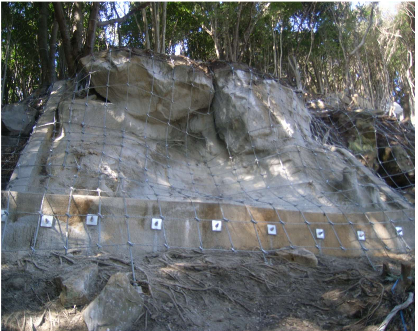
不安定な転石を一体化し、滑動と転倒を抑止した例
